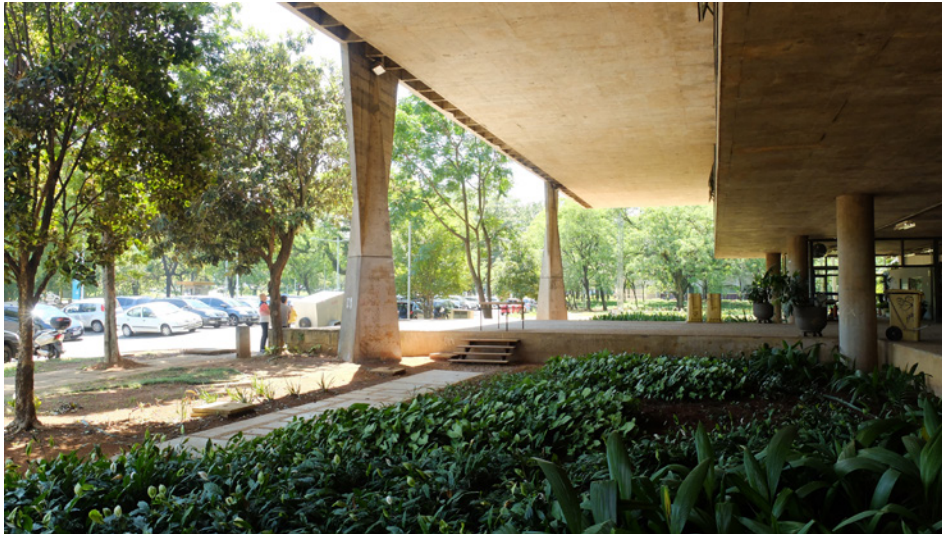
Facultad de Arquitectura - Villanova
